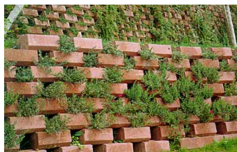
Figura 28 - Barriera antirumore in calcestruzzo ed elementi vegetali
